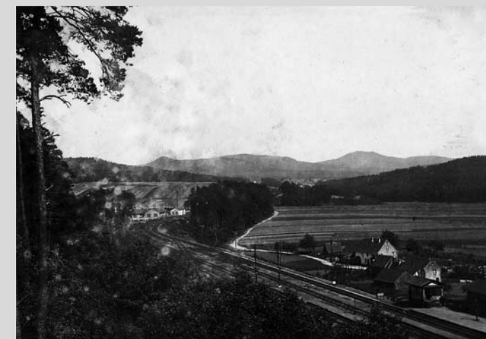
▲ La Verrerie d'Alsace en 1924. Un embranchement ferroviaire permet l'acheminement des matières premières du combustible et l'expédition des objets fabriqués.
